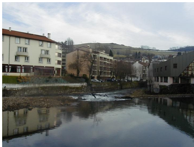
Fig. 5. Dégâts sur le seuil lors de la crue de 2003 – Aurillac
